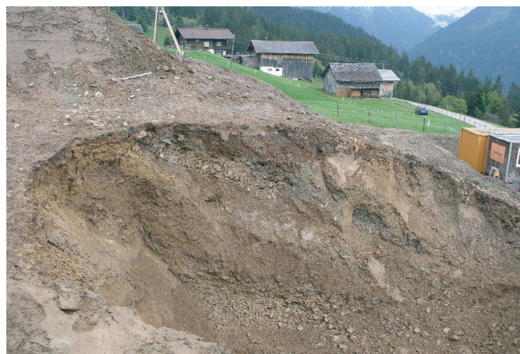
Abb. 29: Kristberg, Gem. Silbertal. Parzelle 604. Nach Pfingsten 2006 wurden die Aushubarbeiten fortgesetzt. Das Foto zeigt einen Zwischenstand und ein Baugrubenprofil, das verschiedene Haldenschüttungen zeigt, die unter dem Niveau der Kulturschichtreste mit Feuchtbodenerhaltung lagen (vgl. Abb. 34).
