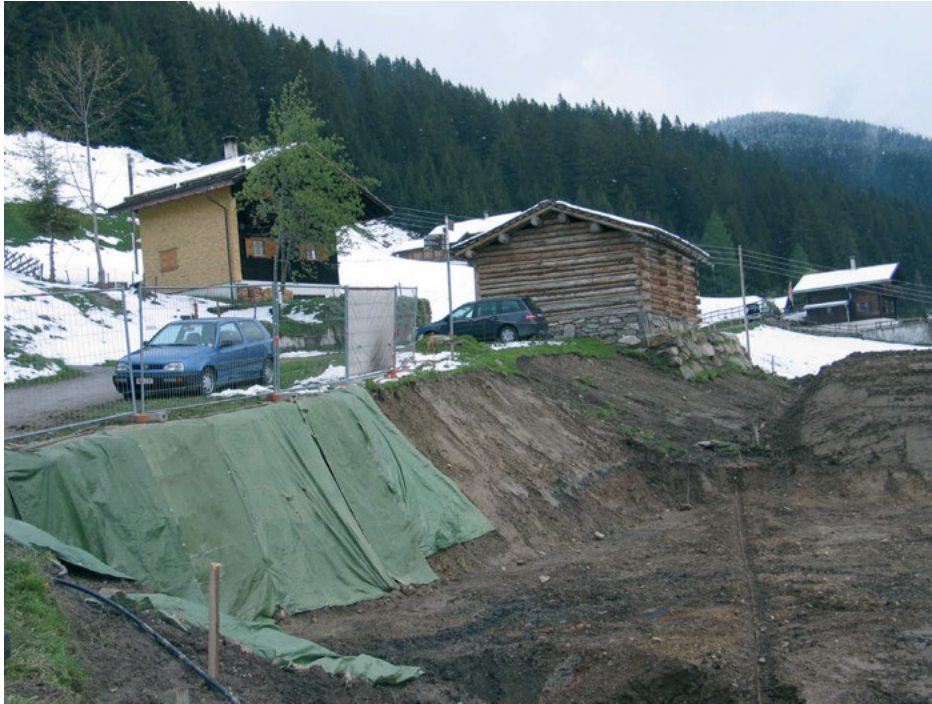
Abb. 24: Kristberg, Gem. Silbertal. Parzelle 604. Zustand der an Pfingsten 2006 zur Hälfte ausgehoben Baugrube. Auf diesem Niveau lagen eingebettet in Haldenschüttungen die schwarze Kulturschicht, vgl. Abb. 33 und 34, Nr. 2, 3.
