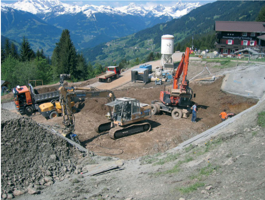
Abb. 31: Kristberg, Gem. Silberral. Parzelle 604. Zustand der Aushubarbeiten nach Pfingsten 2006. Die Baugrubenwände sind bereits mit Spritzbeton versiegelt, in der rechten Baugrubenecke ist an der Westseite noch die alte Oberfläche mit dem Holzkohleband zu erkennen (vgl. Abb. 32 und 33). Im Hintergrund der Panoramagasthof Kristberg.
