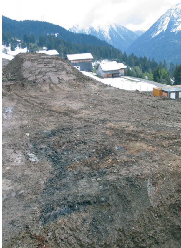
Abb. 28: Kristberg, Gem. Silbertal. Parzelle 604. Zustand der etwa zur Hälfte ausgebaggerten Baugrube an Pfingsten 2006. Im Vordergrund ist die schwarze Kulturschicht Befund Nr. 2 und 3 zu erkennen (vgl. Abb. 33).
